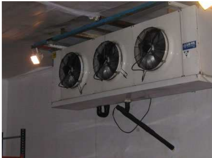
VENTILADORES DEL SISTEMA DE LA CÁMARA FRIGORÍFICA
