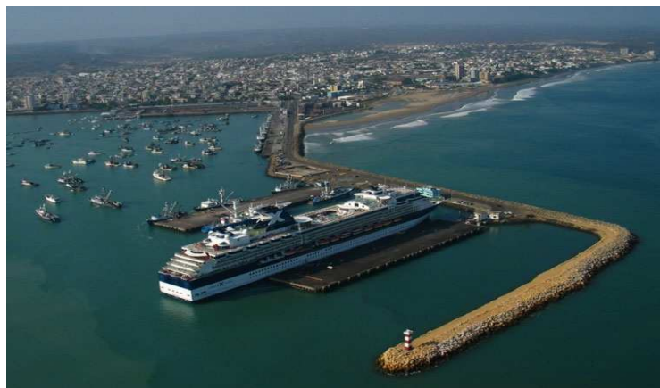
Puerto de Manta
