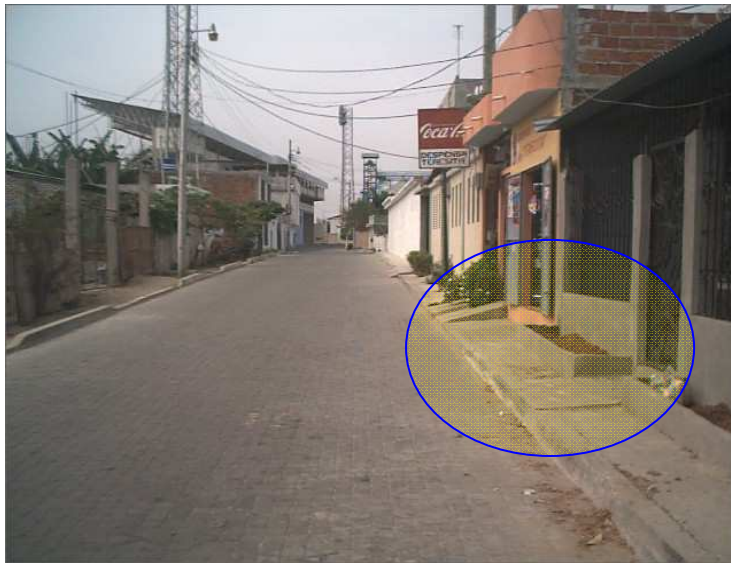
Fotografía # 13: Las jardineras de esta residencia obstruyen la movilidad en la acera.
