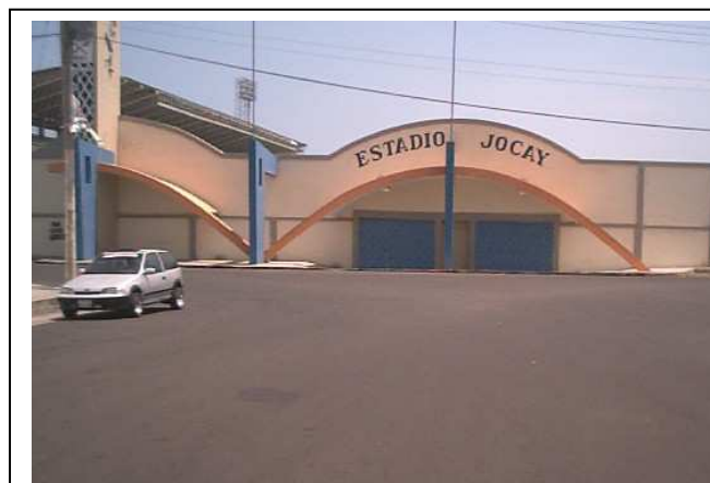
FOTOGRAFIA # 3: Vista del acceso principal al Estadio Jocay. Fuente: Archivo de tesis.
