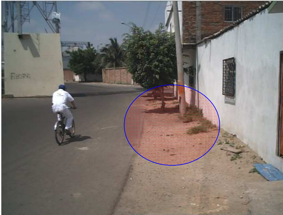
Fotografía # 15: Nótese la falta de diseño técnico de la Vía acera, calzada.
