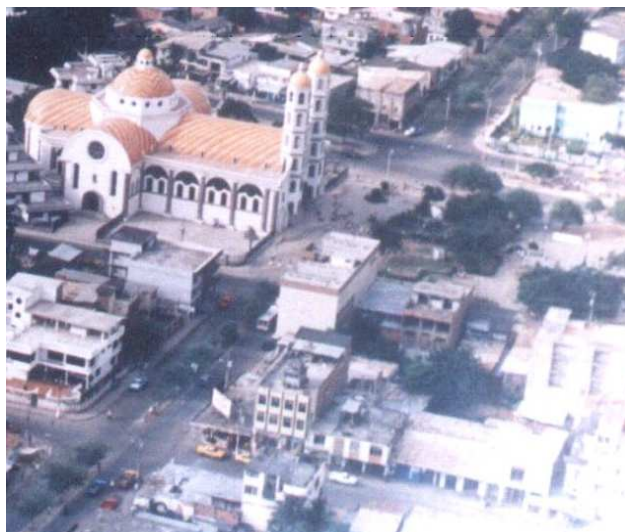
Así luce la Av. Alajuela hoy Después del cierre de la misma, unificándose la Iglesia Catedral con el Parque Eloy Alfaro
