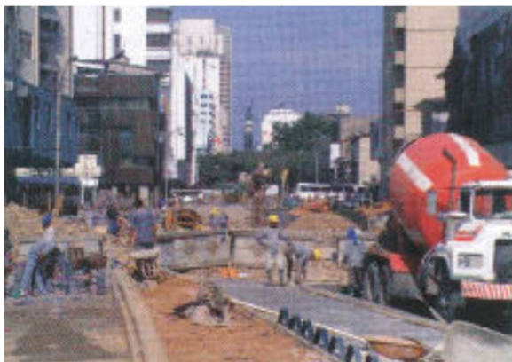
Reconstrucción de la Avenida 9 de Octubre
