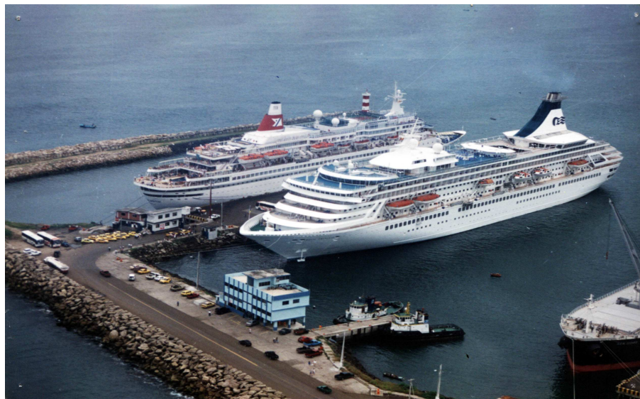
Foto # 13 Muelle de aguas profundas
