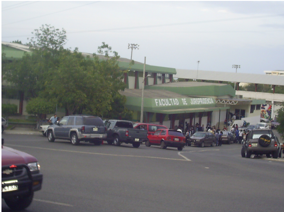
Foto N. 3.- Caos en la circulación vehicular y peatonal por la falta de planificación en el parqueo de los vehículos incluso en las aceras
