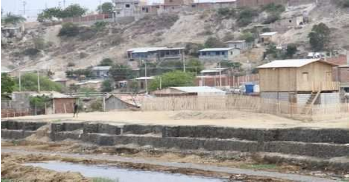
Asentamiento “Barrio 15 de septiembre” Manta. Las casas están en las márgenes del río Manta que en invierno crece e inunda las casas.
