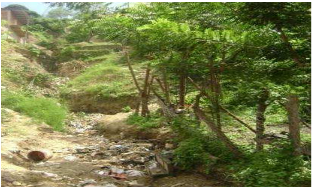
Figura 21 Fotografía de la parroquia Andrés de Vera, acumulación de basuras en drenajes naturales, generación de cárcavas debido a la entrega inadecuada de aguas servidas y de aguas lluvias. Fuente: Fotografía realizada en la zona alta de la parroquia Andrés de Vera, Ciudadela Cevallos, Junio 2017. Elaborado por: Párraga, D., 2017,
