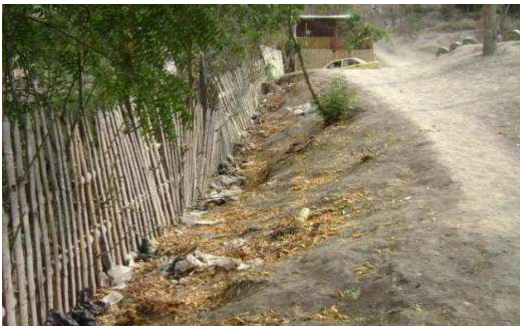
Figura 24 Fotografía del Sector Andrés de Vera, acumulación de basuras sobre las vías.
