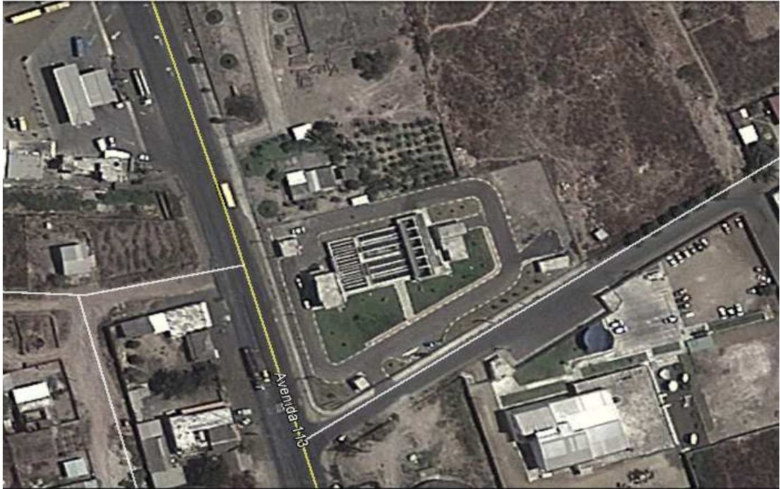
FIGURA 5 PLANTA DE TRATAMIENTO DE AGUA POTABLE UBICADA EN COLORADO
