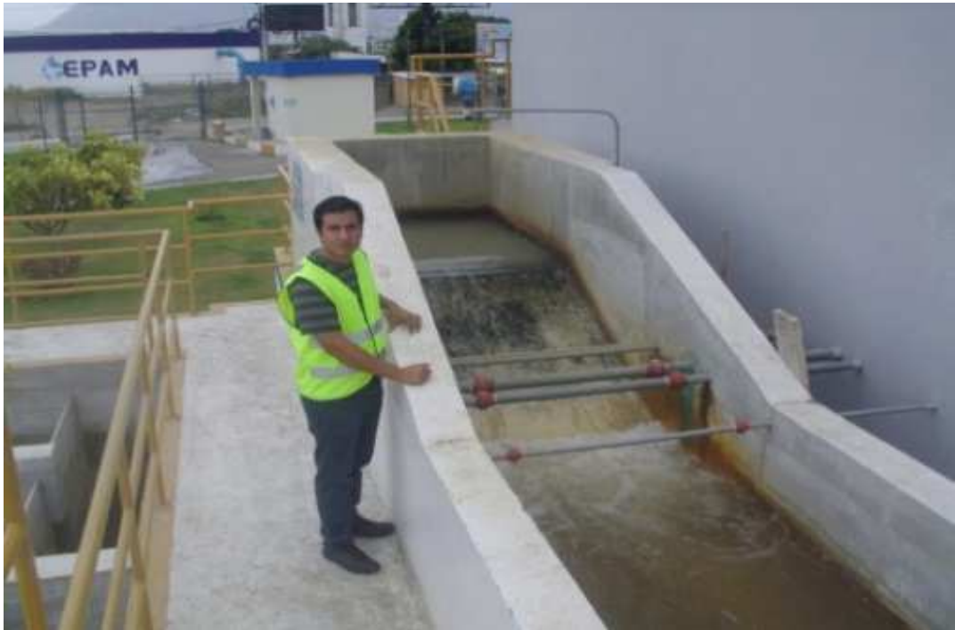
FOTOGRAFIA 1 ENTRADA DE AGUA CRUDA
