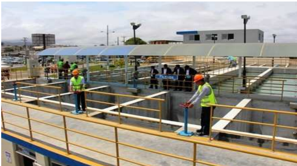
FIGURA 2 LAS INSTALACIONES DE LA PLANTA
