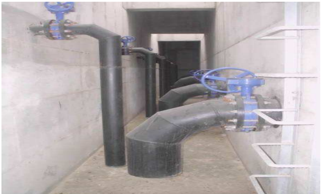
FOTOGRAFIA 3 AREA DE VALVULAS DE PURGAS DE FLOCULADORES Y SEDIMENTADORES
