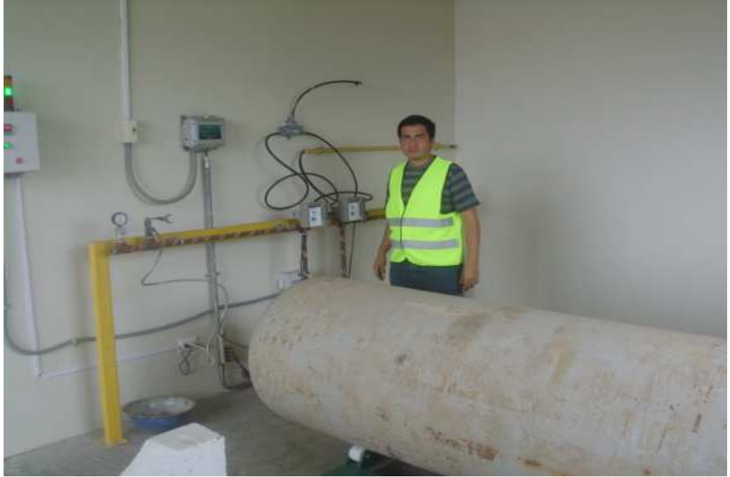
FOTOGRAFIA 7 BODEGA DE CLORO
