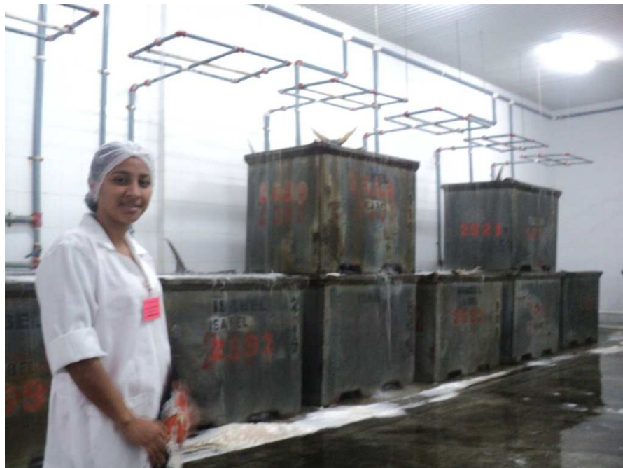
Foto 2. Cámara de enfriamiento mediante cascada.
