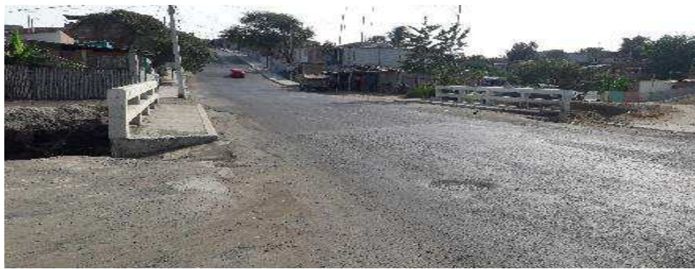
Anexo 5: Puente Barrio “Santa Clara” (Protección Poste - Viga)
