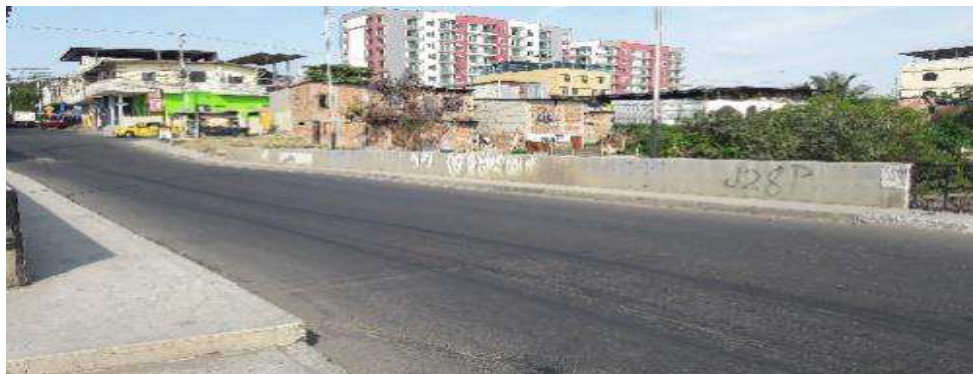
Anexo 6: Puente Barrio “San Pedro” (Protección Maciza)
