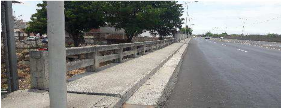
Anexo 4: Puente Vía Puerto – Aeropuerto “Ciudad Rodrigo” (Protección Poste - Viga)
