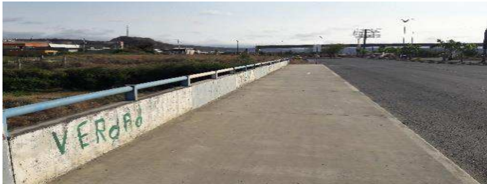
Anexo 8: Puente Av. de la Cultura (Protección Combinada)
