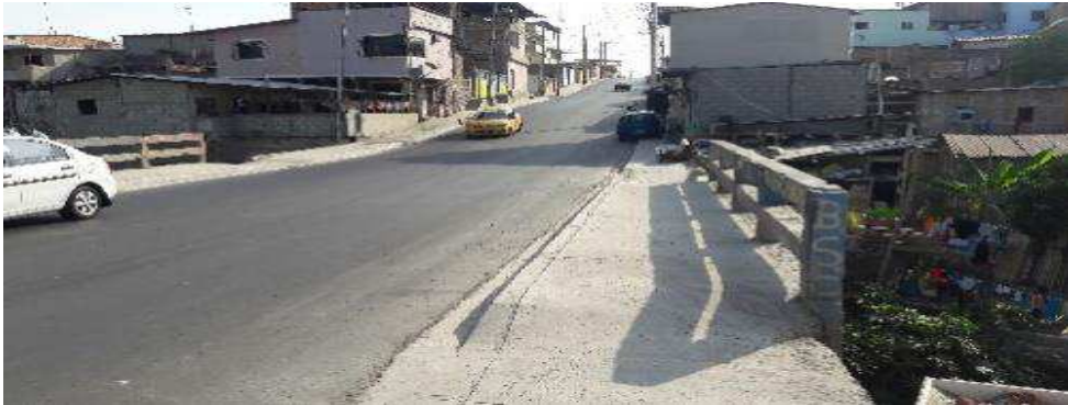
Anexo 7: Puente Barrio “San Pedro” (Protección Poste - Viga)
