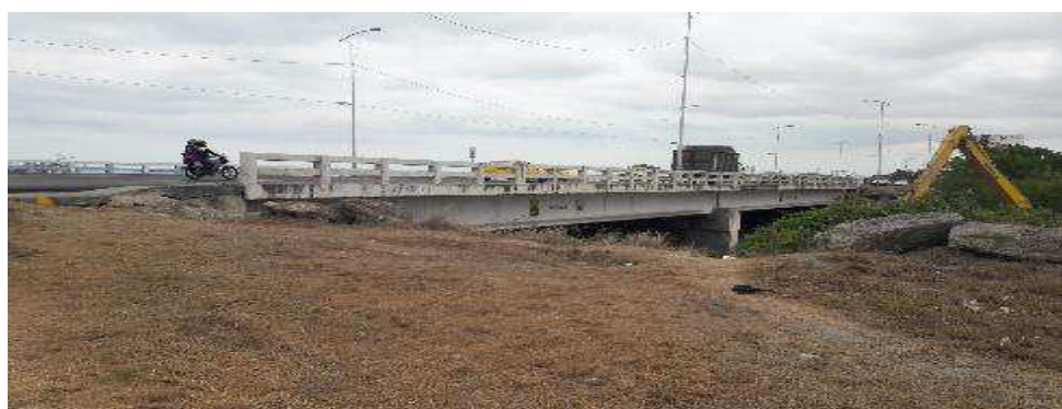
Anexo 3: Puente Vía Puerto – Aeropuerto “La Poza” (Protección Poste - Viga)
