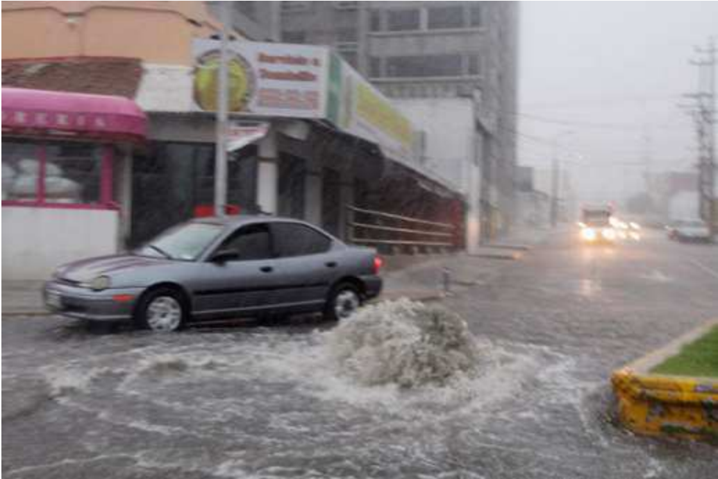
Figura A12.1. Pozo pluvial vertiendo agua hacia la calle, debido a un mal funcionamiento del sistema o una tormenta muy superior a la usada para el diseño.
