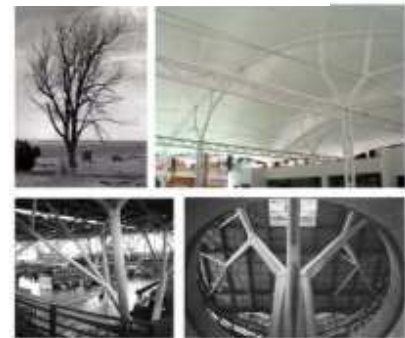
Las estructuras arborescentes permiten reducir drásticamente la luz de flexión y, por tanto, aligerarlas considerablemente (Acuario de Albufeira, 2007 y Aeropuerto de Stuttgart, 1996).
