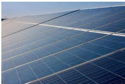
Ilustración 8: Panel solar fotovoltaico policristalinos
