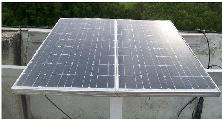
Ilustración 48: Colocación de los 2 paneles solares en uno solo
