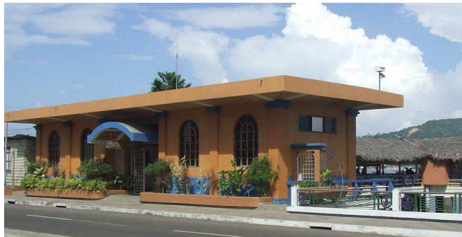
Grafico No. 10. Foto de: http://www.puertoamistad.com Vista del estado actual de la Empresa. Fuente: Internet.
