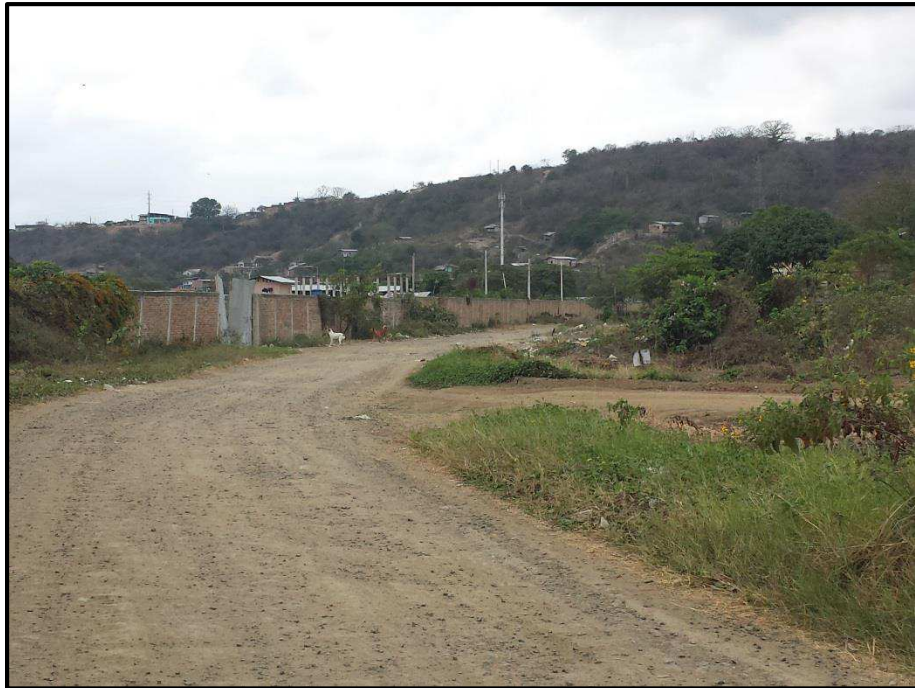
Foto 1.- Estado de la vía.
