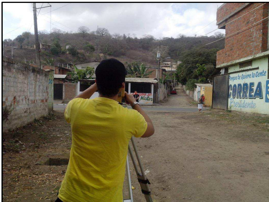
Foto 6.- Fin del tramo de la vía.
