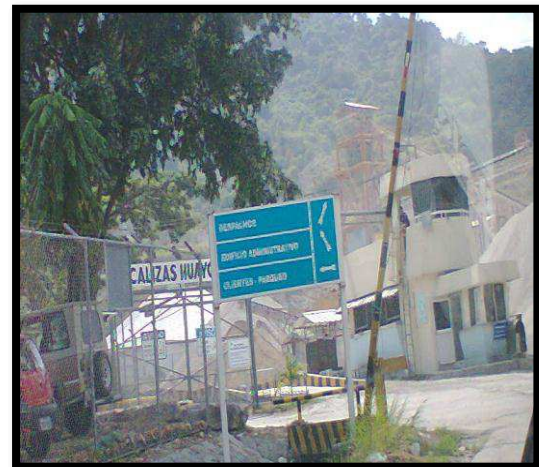
ANEXO B4: Ingreso a la Planta Caliza Huayco
