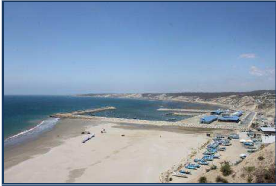
Figura 27. Panorámica de la sedimentación lateral
