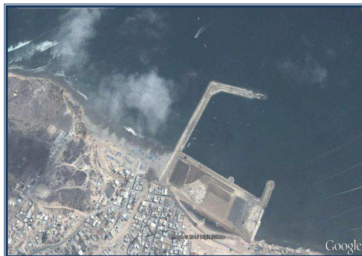
Figura 20. Muelle antes de la sedimentación lateral
