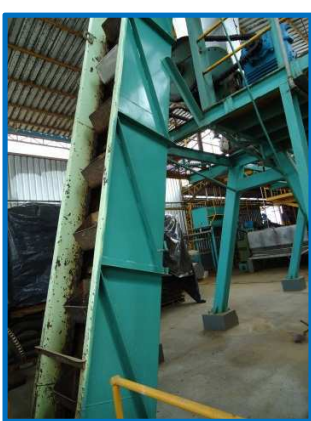
FIGURA N°20. ELEVADOR DE CANGILONES.
