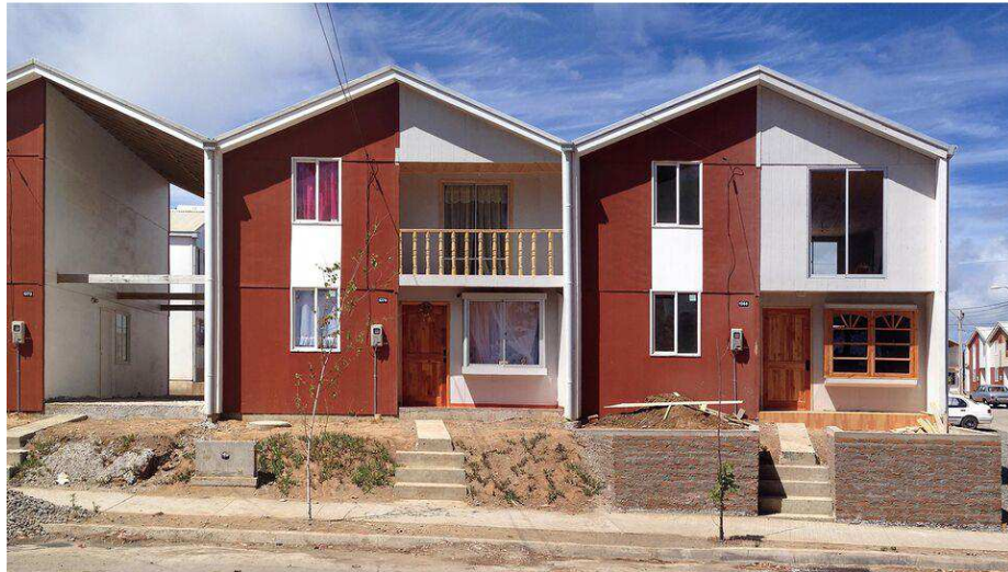
Imagen N° 7 – Proyecto de vivienda de interés social progresiva “Villa Verde”
