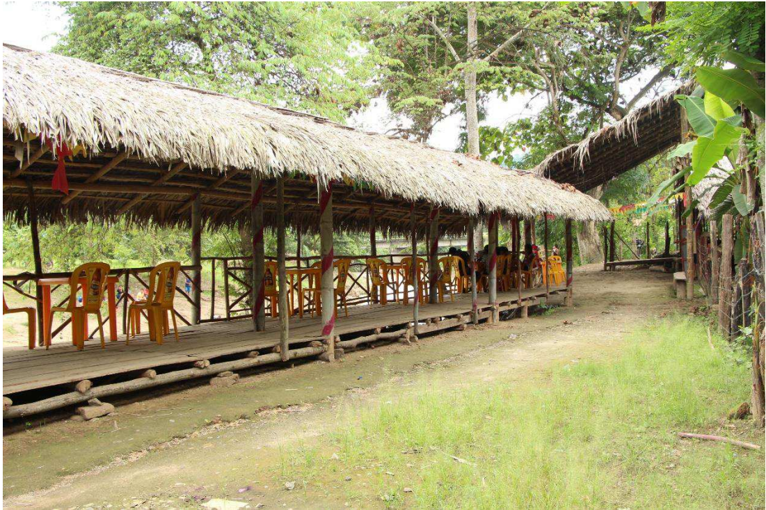
Figura No. 67: Estado actual del mirador al rio Guineal del Balneario “las piedras”.
