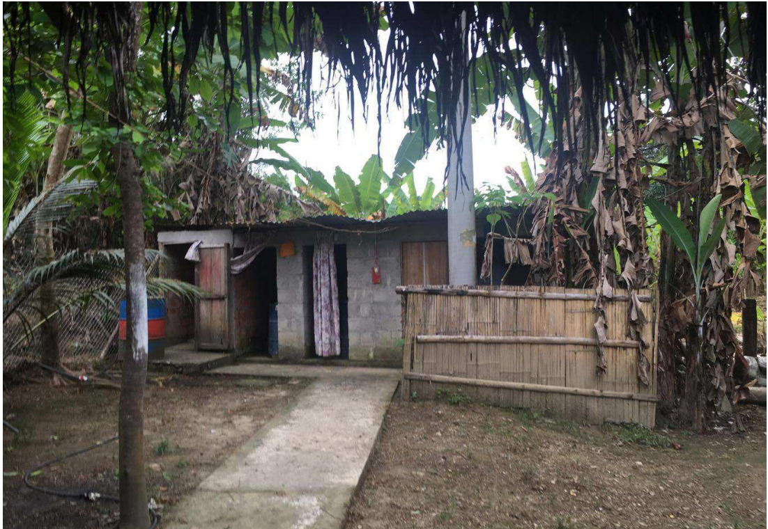
Figura No. 59: Estado actual de las baterías sanitarias del Balneario “las piedras”.
