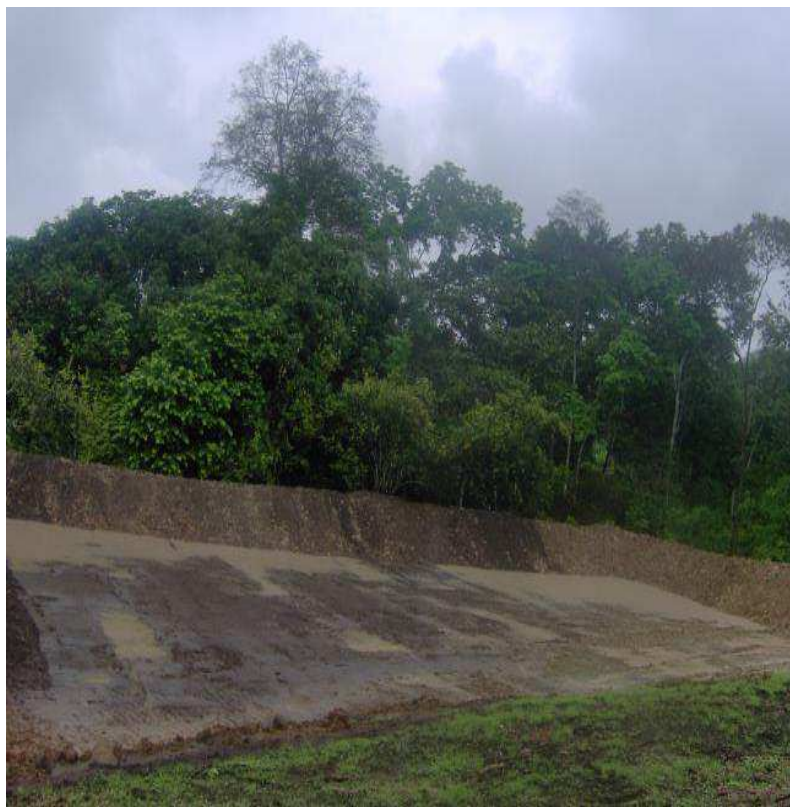
Foto 7. Construcción del estanque.
