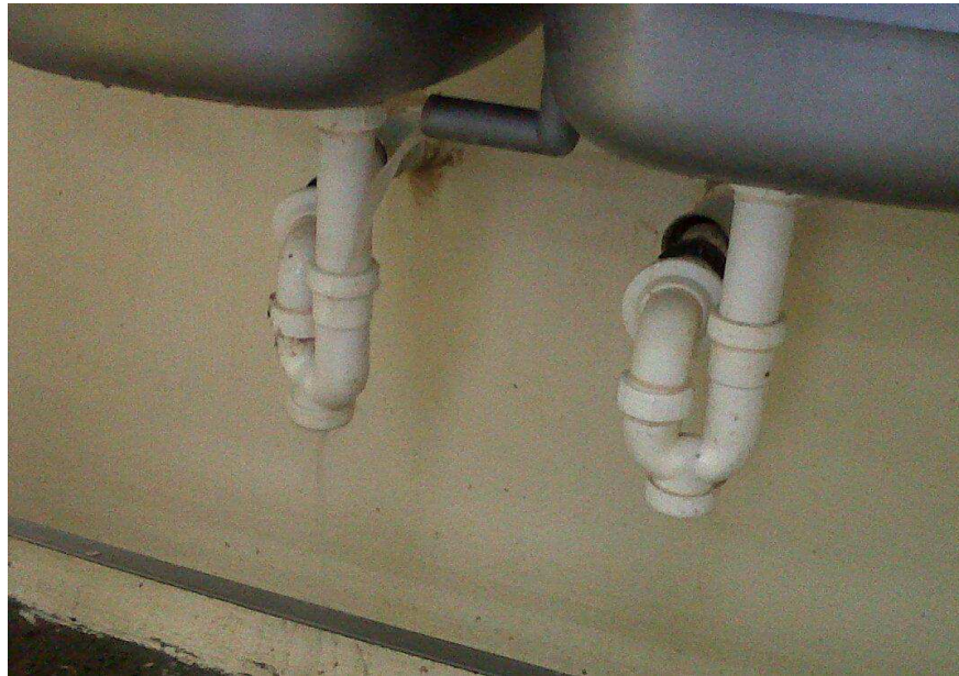
Anexo 3. Tuberías en malas condiciones.
