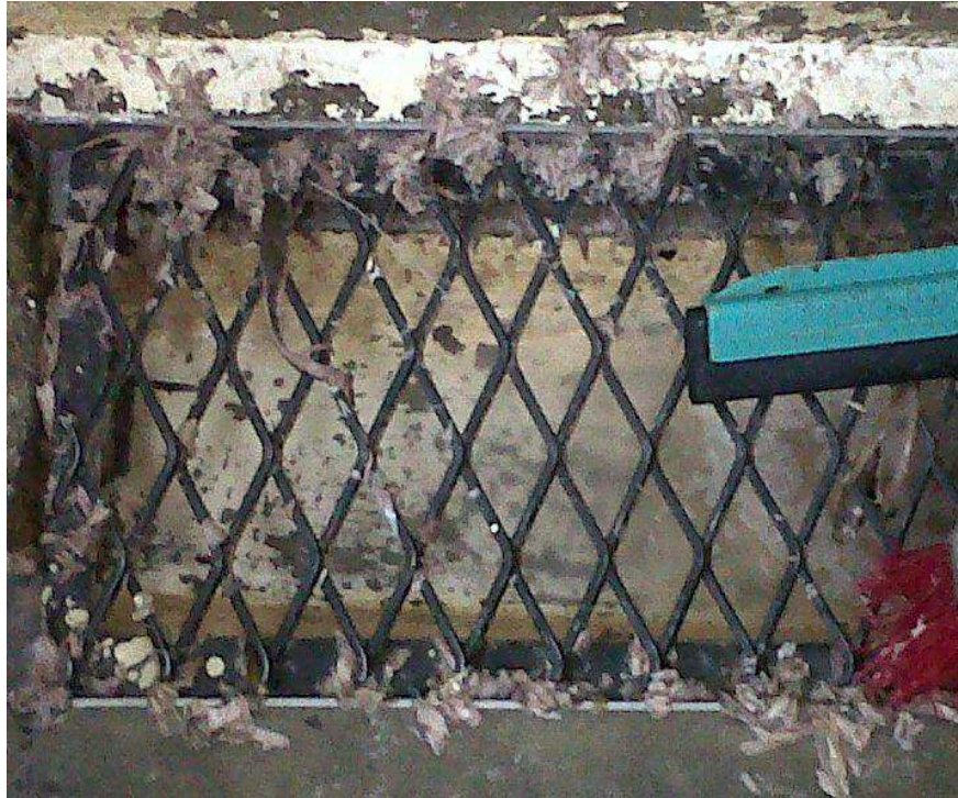
Anexo 5. Rejillas sucias.
