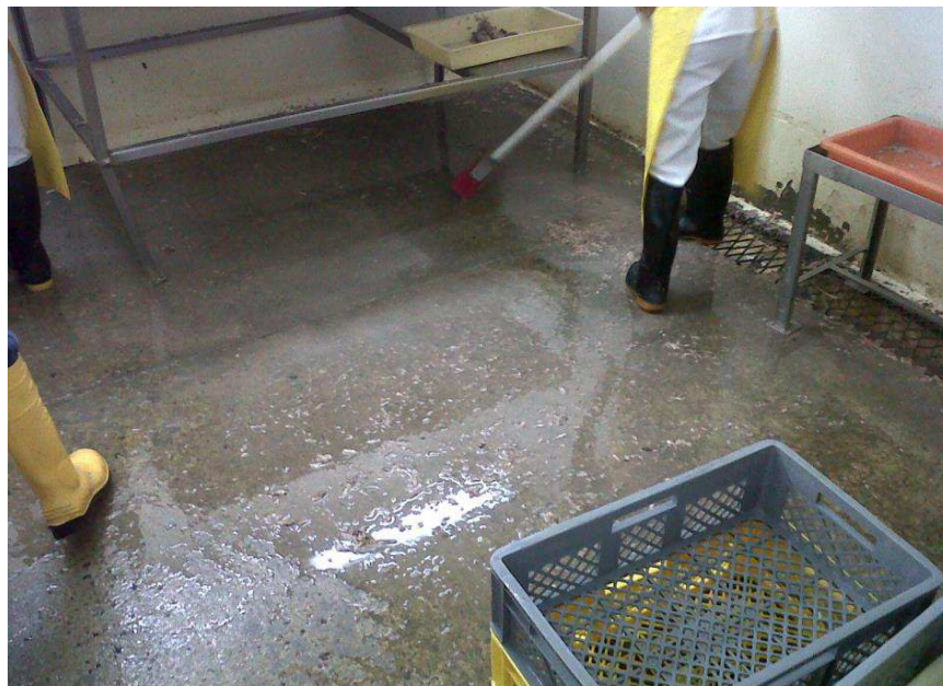
Anexo 4. Pisos sucios por la mala condición de lavaderos.
