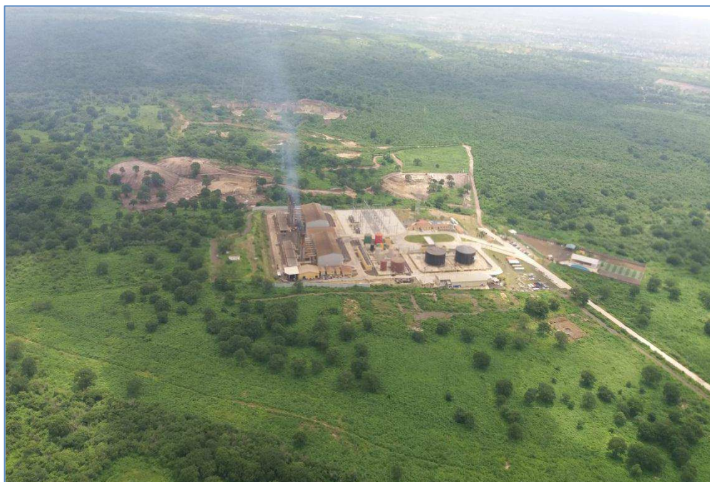
Figura 17.- La Victoria “Comuna Pozos de la Sabana” Afectación Sector Sur
