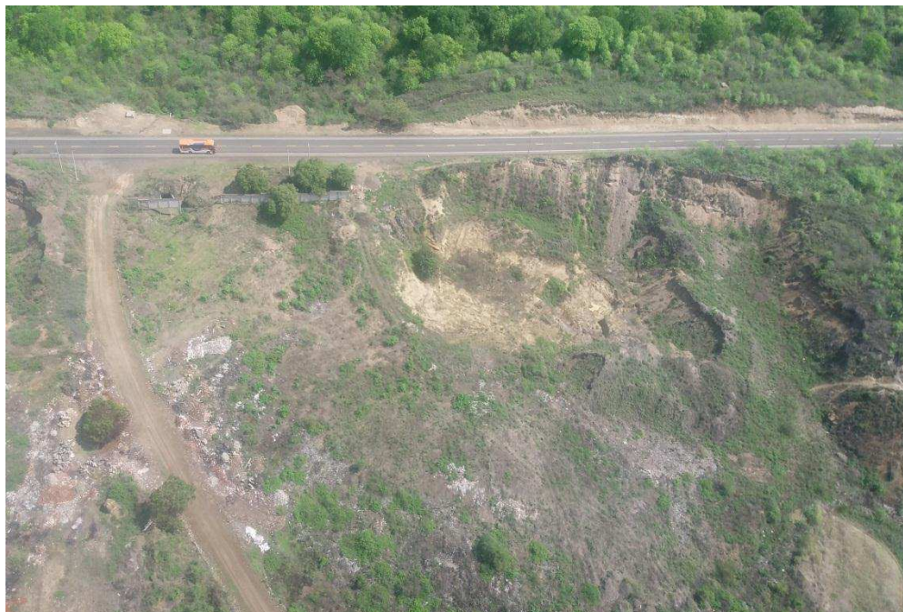
Figura 16.- La Victoria “Comuna Pozos de la Sabana” Afectación Sector Norte
