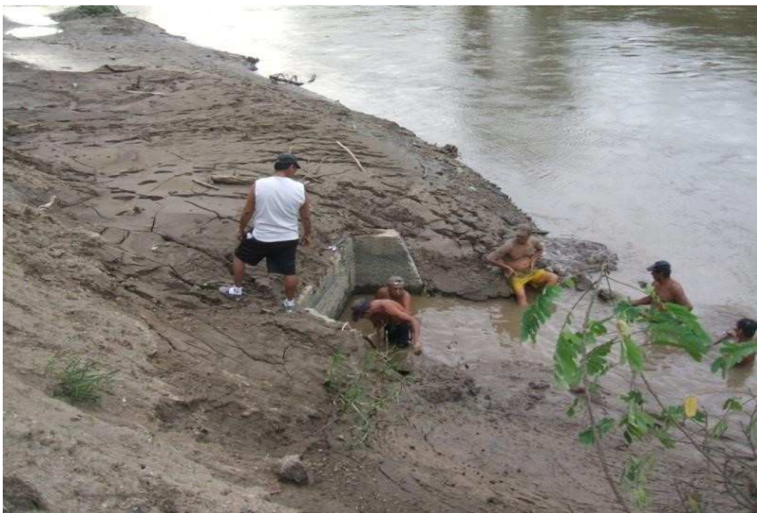
GRAFICO 5.8 LIMPIEZA DE INGRESO DE DESARENADOR
