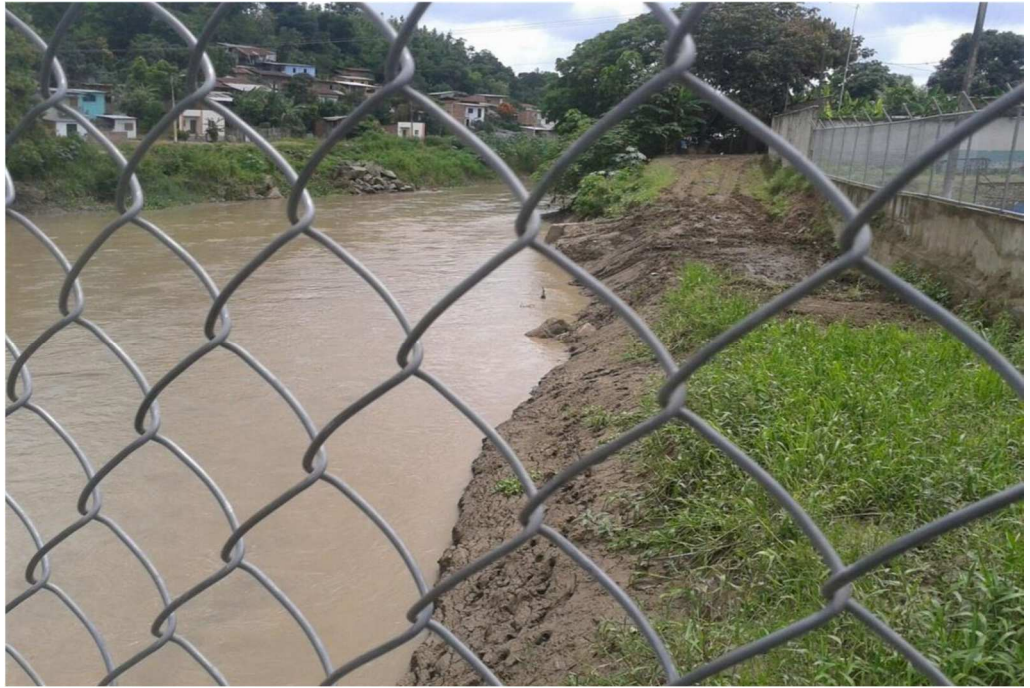
GRAFICO 5.1 AGUAS ARRIBA DE ESTACION DE BOMBEO
