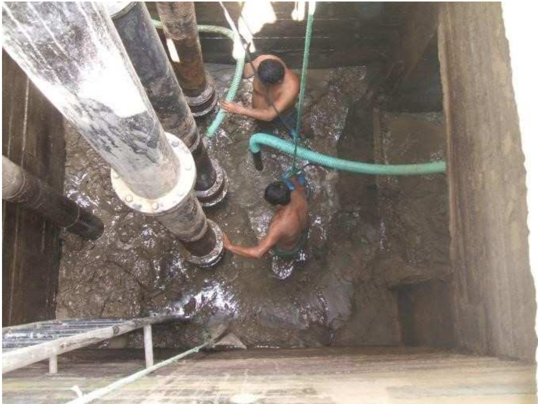
GRAFICO 5.7 LIMPIEZA DE ESTACION DE BOMBEO
