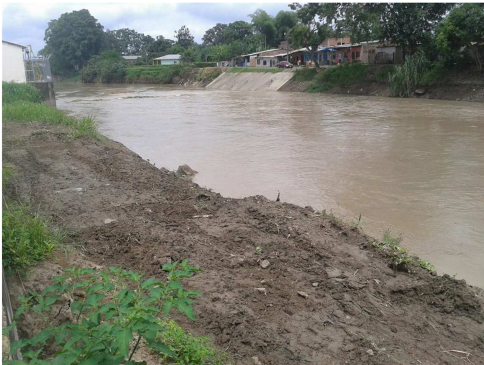
GRAFICO .1.4 ZONA AZOLVADA POR SEDIMENTOS.
