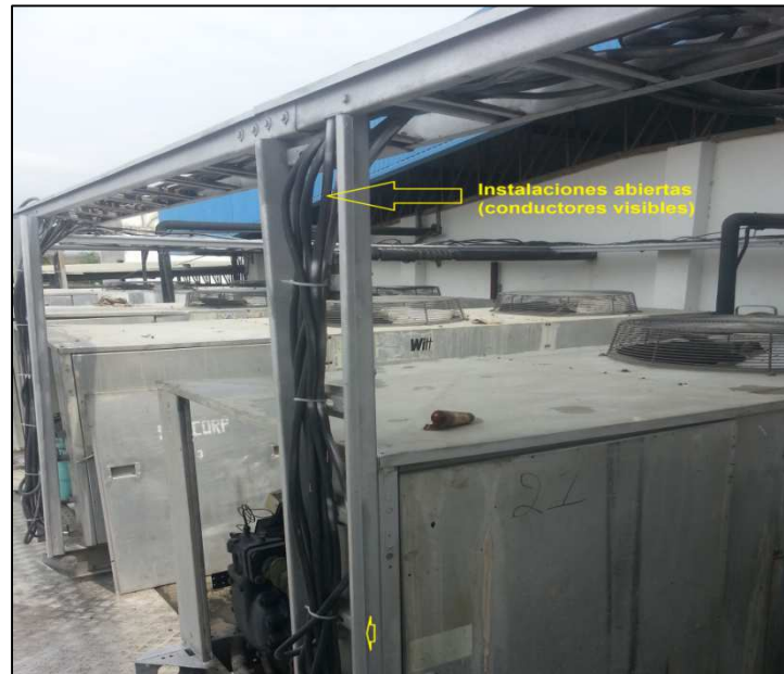
fig. 27 Instalaciones eléctricas abiertas en Fishcorp
