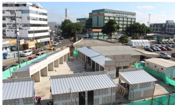
Figura 2. Construcción de la plaza comercial.
