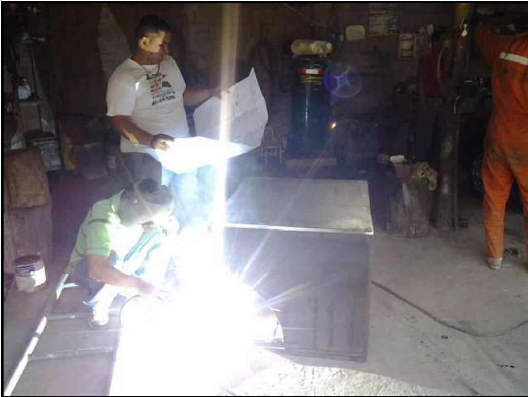
ANEXO 3, soldadura del depósito para unidad de potencia hidráulica.
