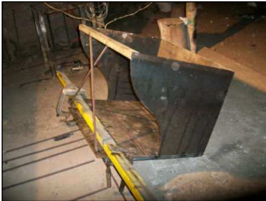
Figura 20. Depósito hidráulico durante el proceso de soldadura.
