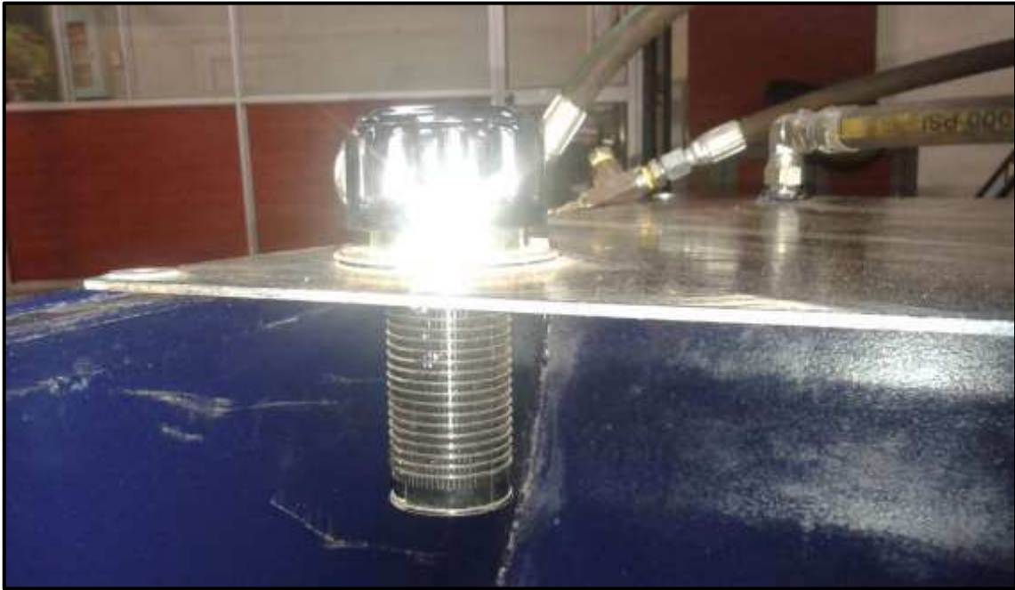
ANEXO 11, respiradero del depósito hidráulico.
