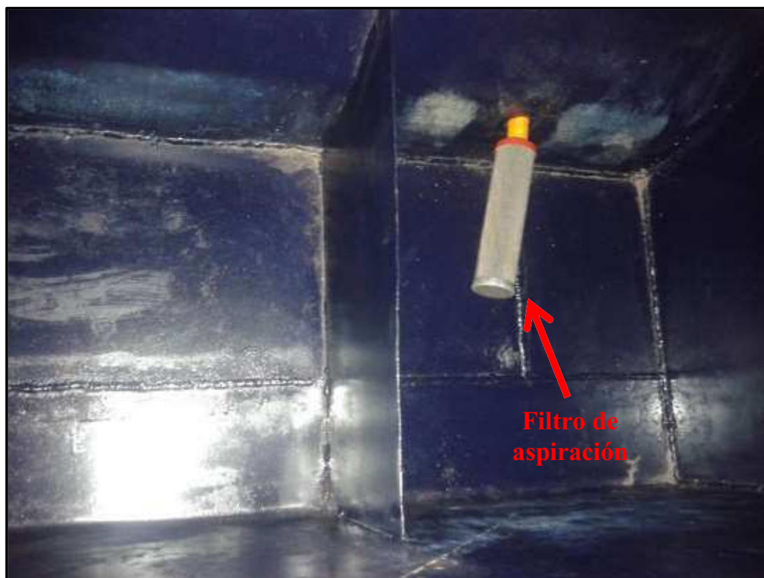
ANEXO 10, vista del filtro de aspiración.
