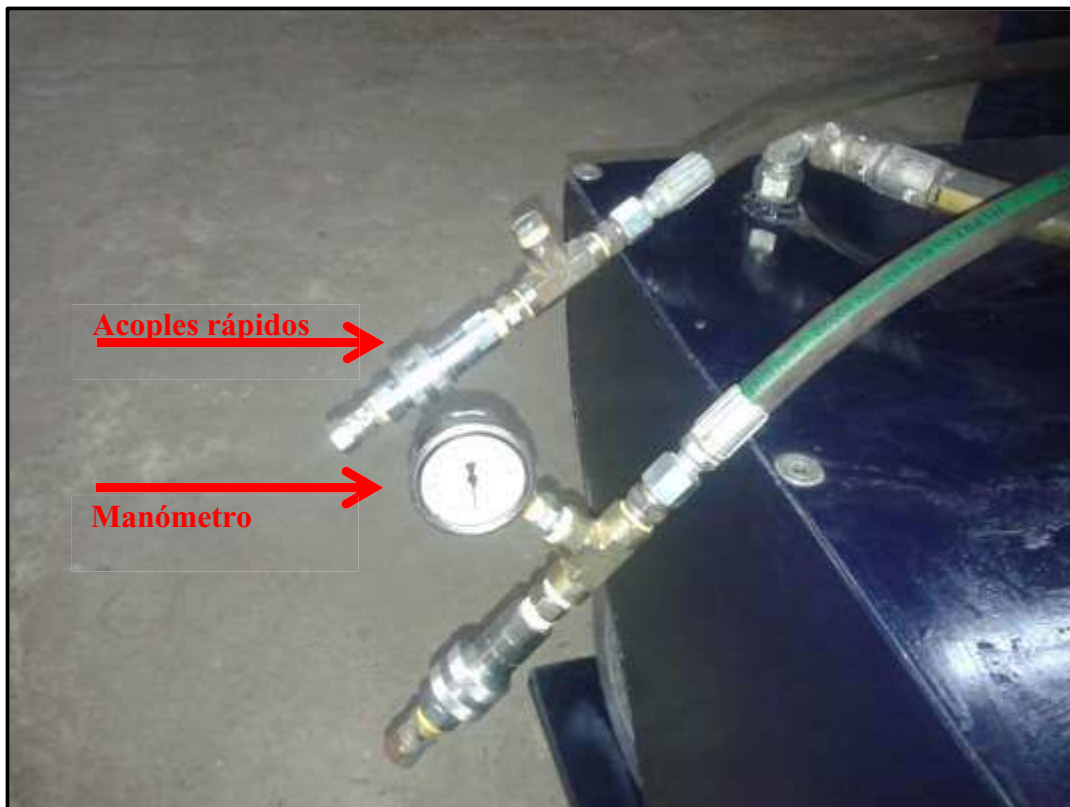
ANEXO 9, vista de los acoples rápidos y el manómetro de las mangueras.
