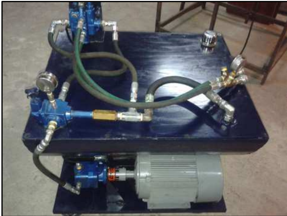
Figura 23. Válvulas de la Unidad de Potencia Hidráulica Fuentes: autores.
