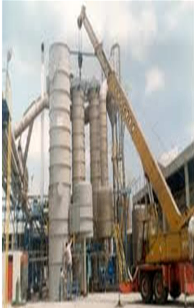
Figura 3: Instalación de planta de agua de cola Fuente: Produpes S.A.
