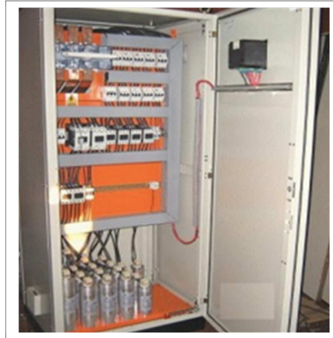
Figura 20: Tablero Eléctrico Fuente: Produpes S.A.
