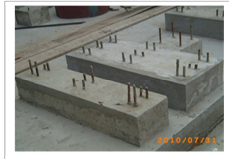
Figura 2: Base de Bombas Fuente: Produpes S.A.
