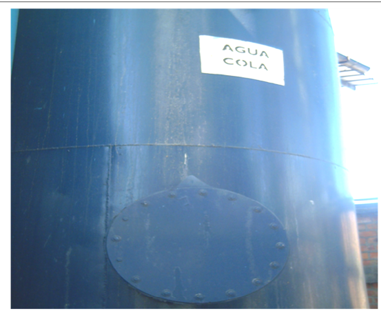
TANQUE DE ALMACENAMIENTO DE AGUA DE COLA
