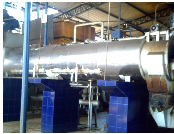
COCINA CON CAPACIDAD PARA 10 TON / HORA
