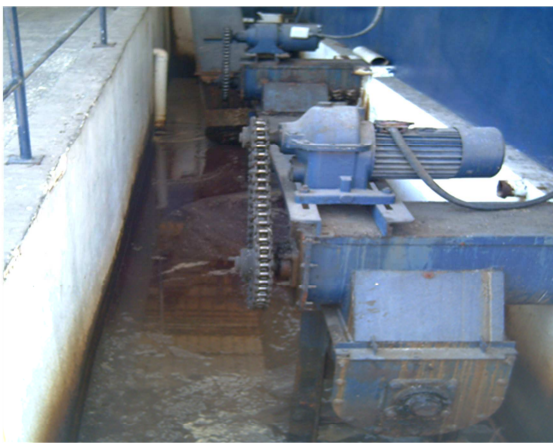
SAGUANZA DE LAS POZAS DE RECEPCIÓN DE MATERIA PRIMA
