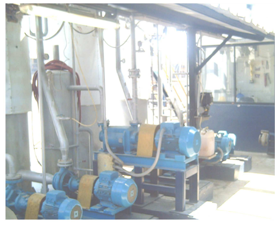
BOMBAS DE OPERACIÓN DE PLANTA DE AGUA DE COLA
