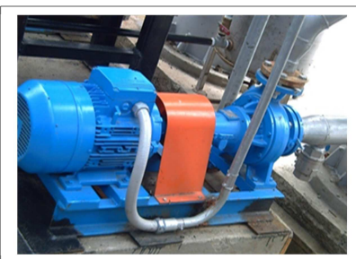
Figura 12: Bomba 1er efecto Fuente: Produpes S.A.
