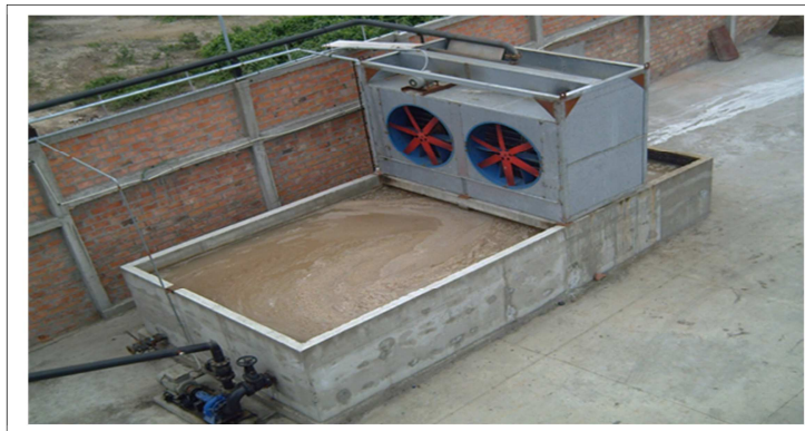
Figura 22: Torre de Enfriamiento Fuente: Produpes S.A.
