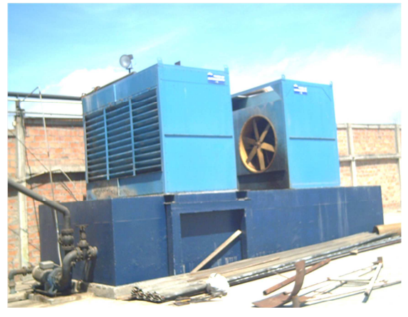
TORRE DE ENFRIAMIENTO CON PISCINA DE RECEPCIÓN
