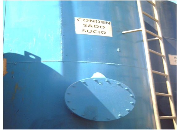
TANQUE DE ALMACENAMIENTO DE CONDENSADO SUCIO
