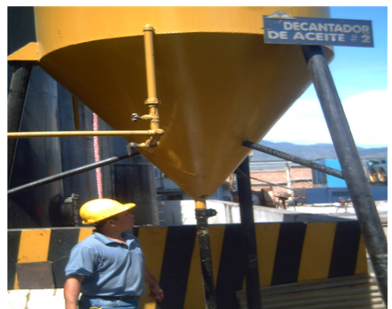
TANQUE DECANTADOR DE ACEITE FUENTE: PRODUPES S.A.
