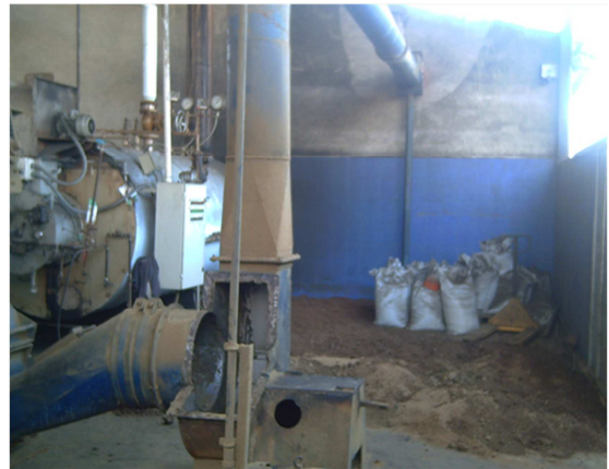
SOPLADOR DE HARINA HACIA LA BODEGA DE ALMACENAMIENTO FUENTE: PRODUPES S.A.
