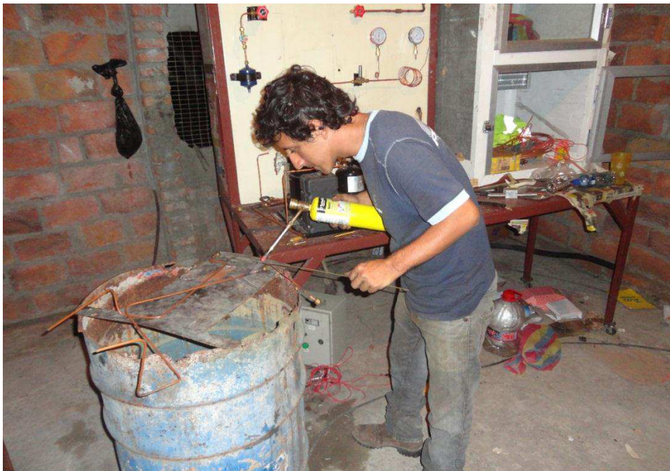
Aplicando soldadura a las cañerías de cobre
