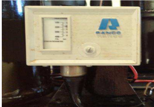
Anexo 17: Presostato de alta
