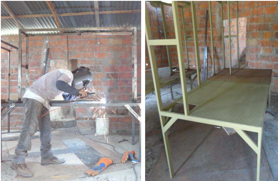
Ilustración 1: Puntos de soldadura - Estructura metálica culminada
