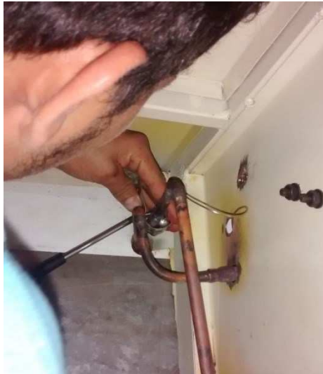
Figura 20: Montaje de bulbo de VET en tubería de succión Elaborado por: Fernando Delgado Mero – Humberto Loor Palma
