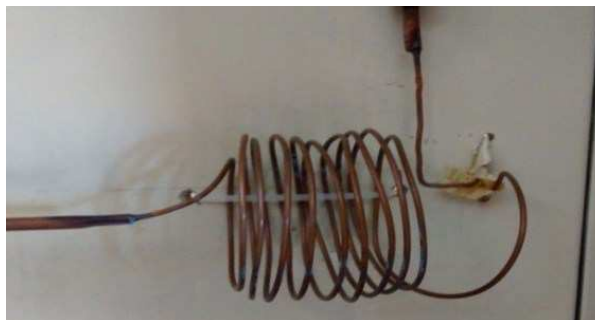
Figura 21: Montaje de tubo capilar de cámara de conservación Elaborado por: Fernando Delgado Mero – Humberto Loor Palma
