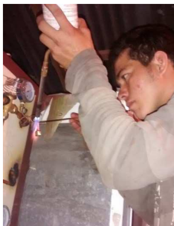
Figura 19: Unión de tuberías con soldadura de plata al 5% Elaborado por: Fernando Delgado Mero – Humberto Loor Palma
