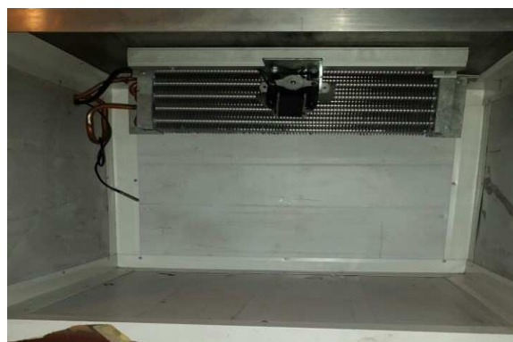
Figura 15: Montaje de evaporador dentro de cámara de conservación Elaborado por: Fernando Delgado Mero – Humberto Loor Palma
