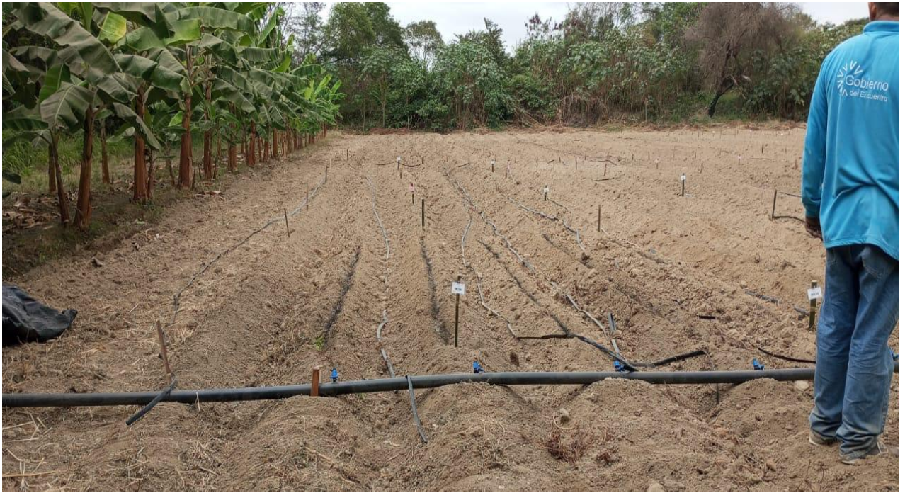
Anexo 3. Instalación de sistema de riego
