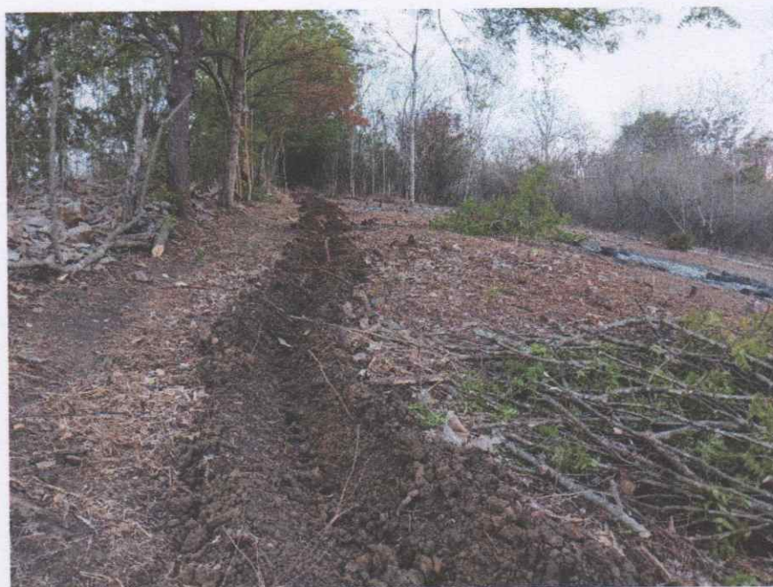
Anexo 2. Proceso de instalación del sistema de riego por goteo
