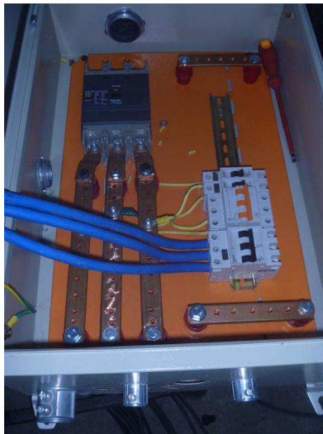
Ilustración 2. Instalación de breaker principal trifásico de 250Amp junto con breker de 100Amp y 80Amp con cables conductores para máquinas CNC véase en la página 62.
