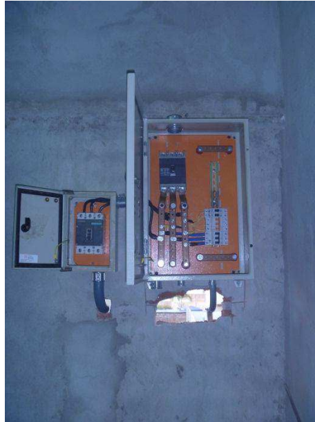
Ilustración 3. Tablero eléctrico junto a toda la conexión eléctrica instalada véase en la página 62.
