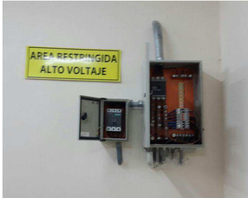
Ilustración 5. Tablero eléctrico instalado con todos sus componentes eléctricos breakers, cables conductores, barras conductoras y terminales véase en la página 62.
