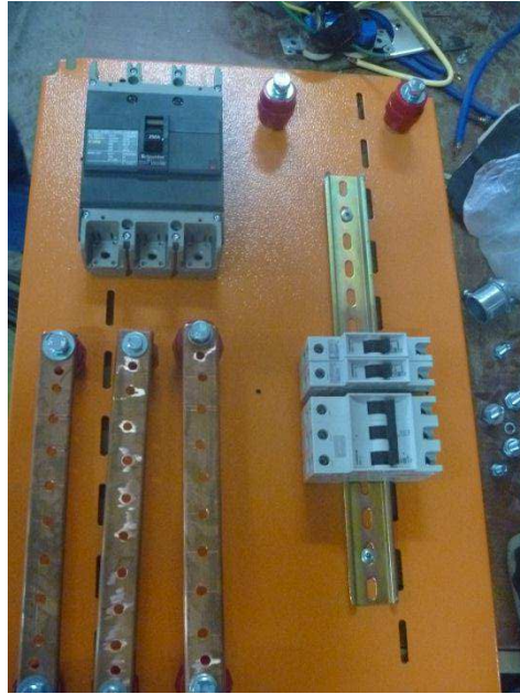
Ilustración 1. Instalación inicial del breaker principal de 250Amp y barras conductoras véase en la página 62.
