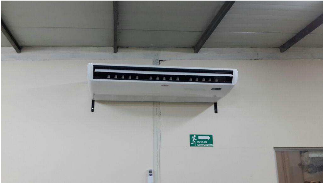
Ilustración 7. Evaporador tipo piso techo instalado para la climatización del taller donde se encuentran las dos máquinas CNC véase en la página 66.
