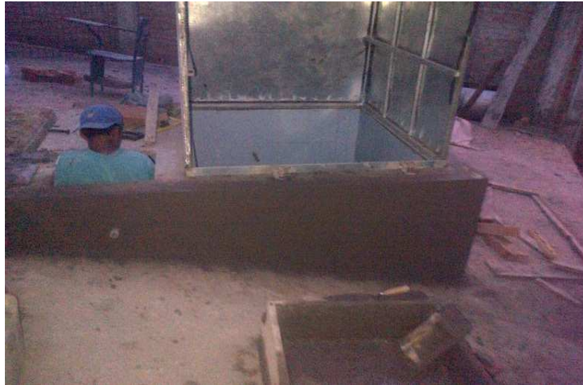
Foto # 10.- Fundición para dejar fijar la estructura de la torre
