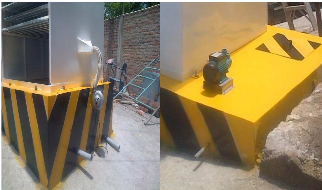
Foto # 12.- Ventilador centrífugo y bomba de agua
