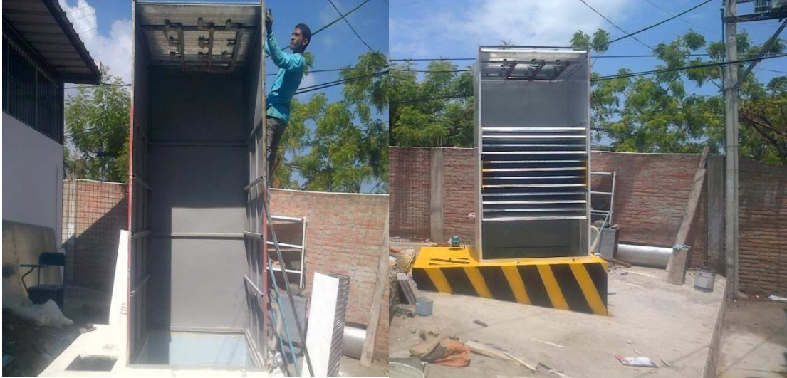
Foto # 11.- Antes y después de la estructura de torre
