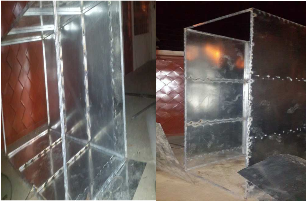
Foto # 5. Añadidura de plancha galvanizada
