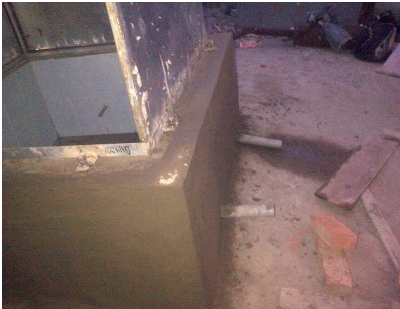
Foto # 13.- Enlucido y terminación de la parte exterior
