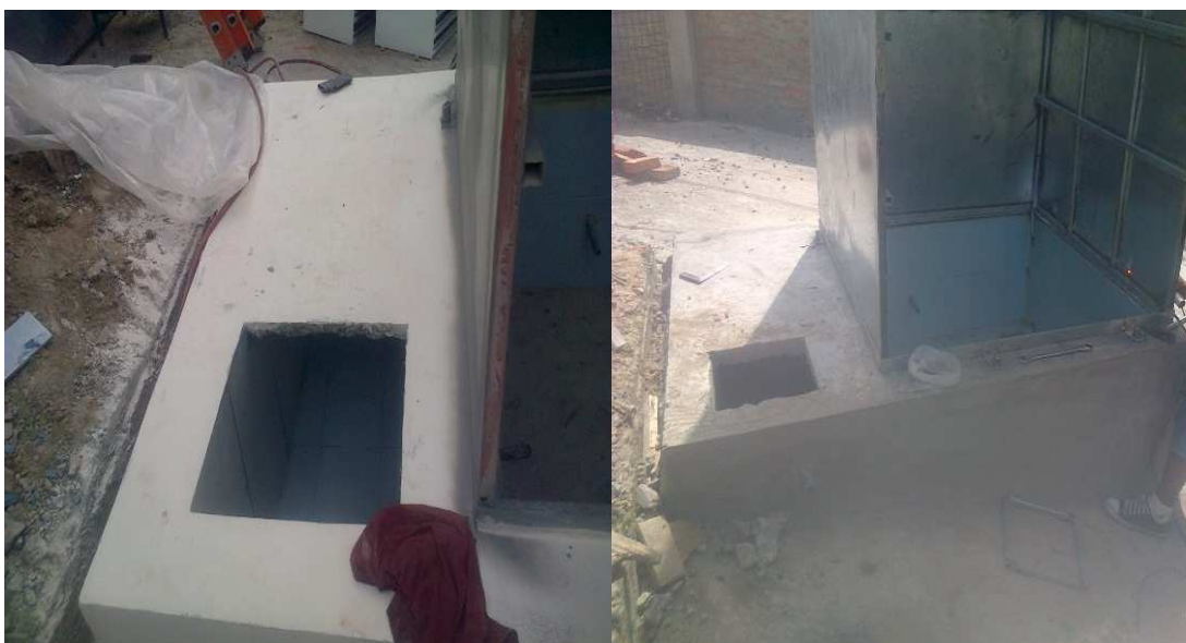
Foto # 11.- Fundición de tapa de concreto
