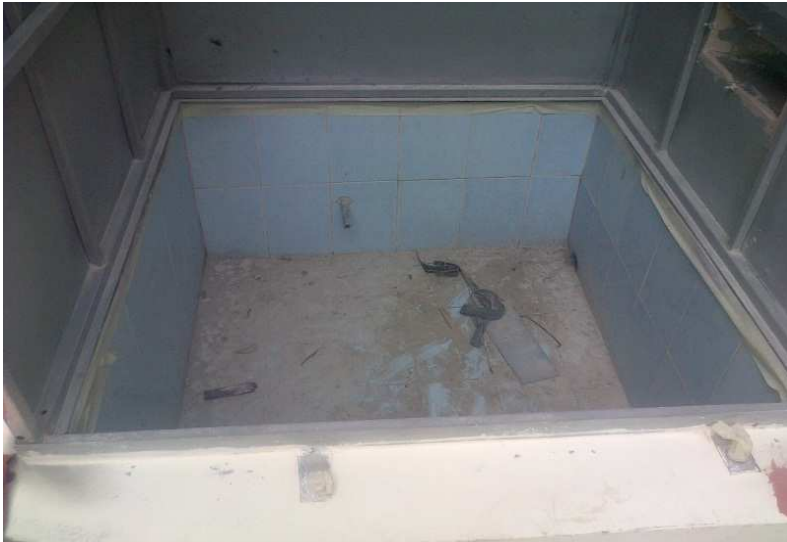
Foto # 12.- Colocación de cerámica y relleno de hendidias con porcelana
