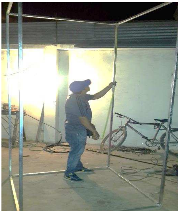
Foto # 3. Añadidura de plancha galvanizada
