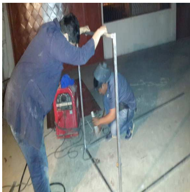
Foto # 2. Soldadura con electrodos 6011 y cuadro de terminales
