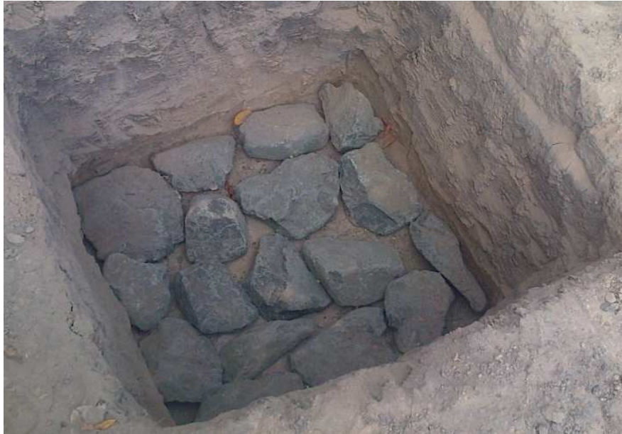
Foto # 9.- Pilotes para construcción de piscina de torre de enfriamiento
