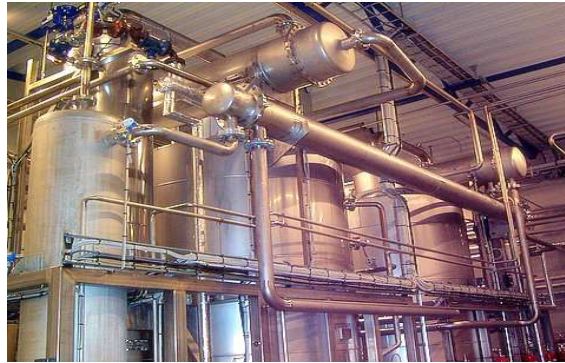
Figura (7). Equipos de compresores térmicos. FUENTE: http://www.codeso.com/EquipoDesalinización.html
