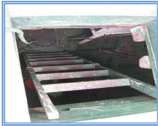
Foto 14: Escaleras y accesos
