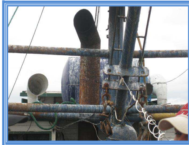
Foto 11: Sistema de Escape de gases de Máquina
