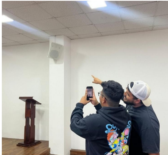
Ilustración 63. Verificación de la directividad de los parlantes.
