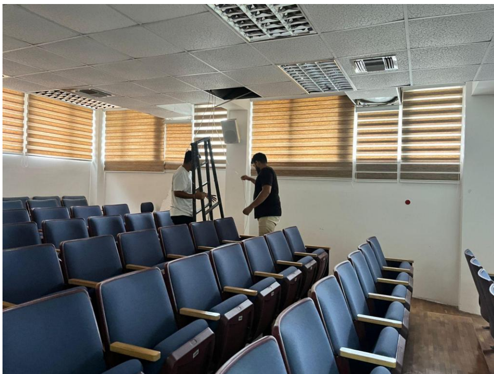
Ilustración 35. Tendido de cables
