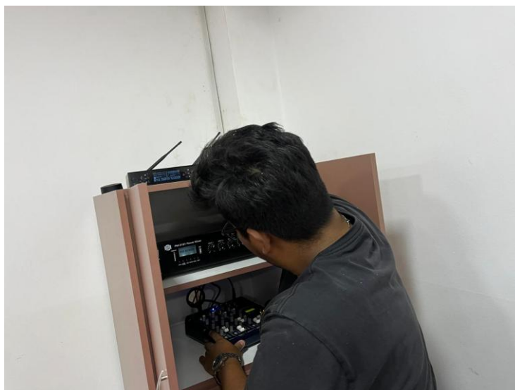
Ilustración 61. Levantamiento técnico de infraestructura en el sitio.
