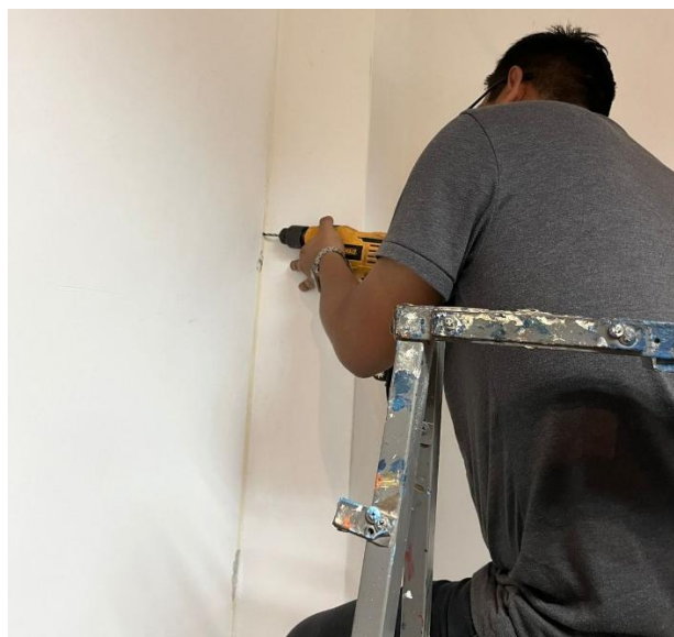
Ilustración 58. Adecuación de Auditorio Leo Cedeño Cabezas
