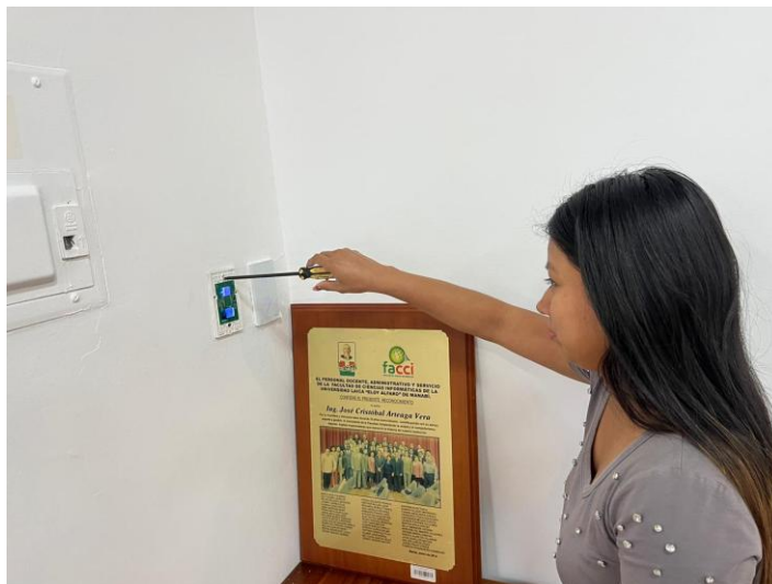
Ilustración 23: Cambio de interruptor
