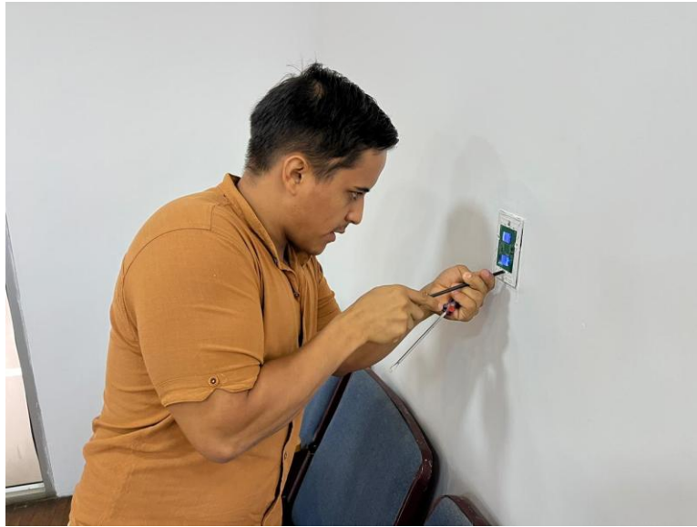
Ilustración 22: Cambio de interruptor
