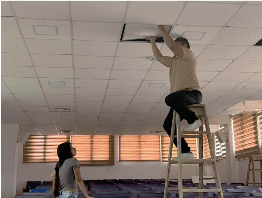
Ilustración 21: cambio de paneles
