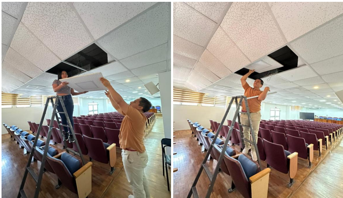
Ilustración 35: Instalación de las nuevas luminarias
