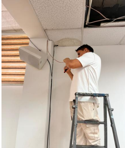
Ilustración 18: Verificando el estado actual del cableado.
