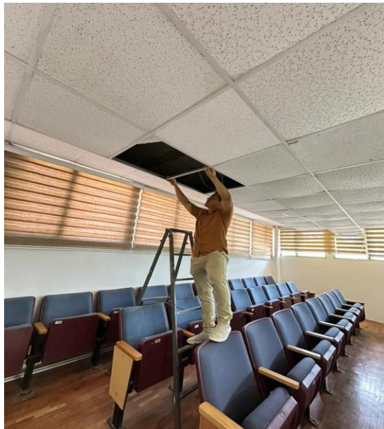
Ilustración 15: Preparación de entorno para luminarias
