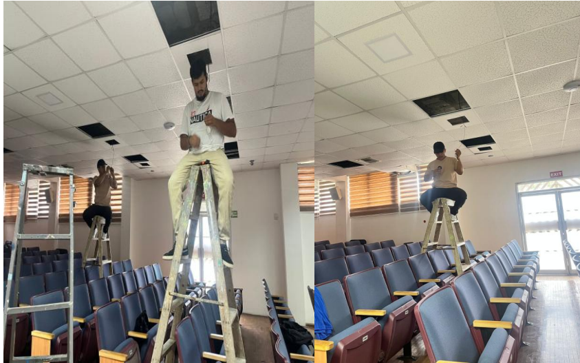
Ilustración 33: Verificación del estado del cable.
