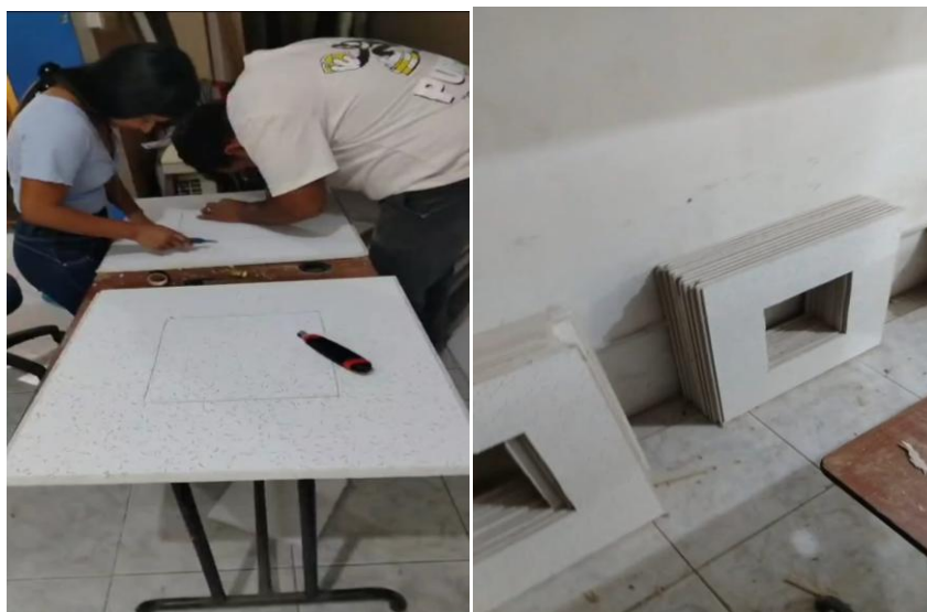
Ilustración 16: Preparación de los paneles para las nuevas luces
