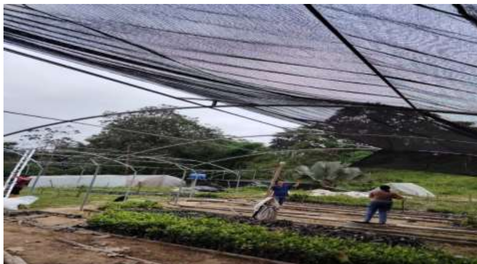
Figura 8. Instalación de la malla sarán en la estructura del macrotúnel para el establecimiento de plántulas de pepino
