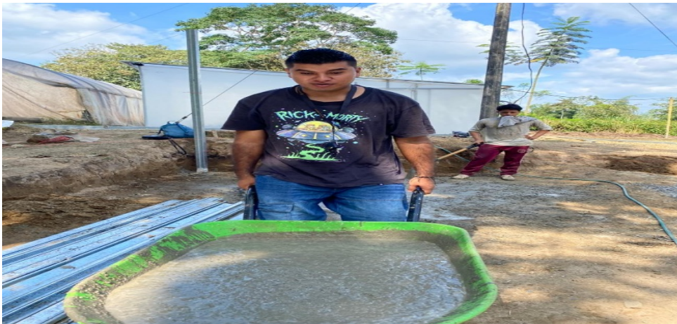
Figura 10. Aplicación de concreto en bases del lombricario
