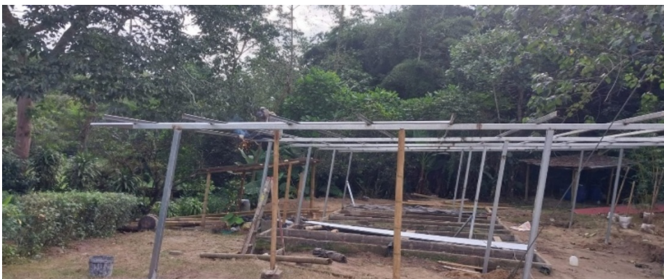
Figura 12. Instalación del techado del lombricario
