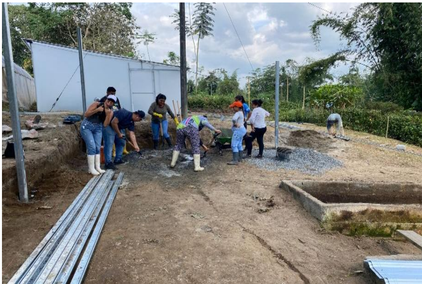
Figura 4. Preparación del área y montaje de la base estructural del sistema de lombricultura
