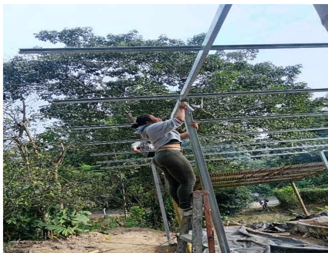
Figura 5. Instalación de la cubierta metálica sobre la estructura del módulo de lombricultura
