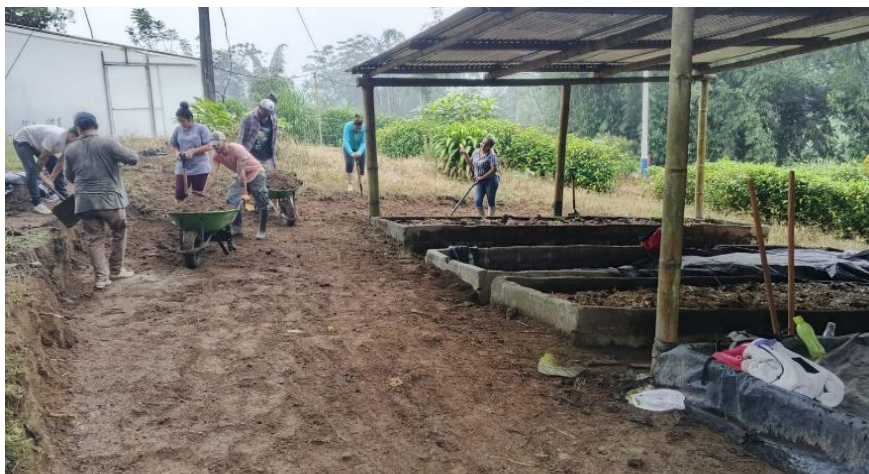
Figura 10. Inspección del área y preparación de los módulos de lombricultura
