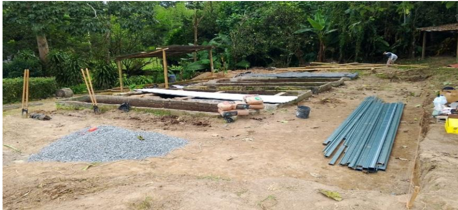
Figura 9. Instalación del techo metálico del módulo de lombricario
