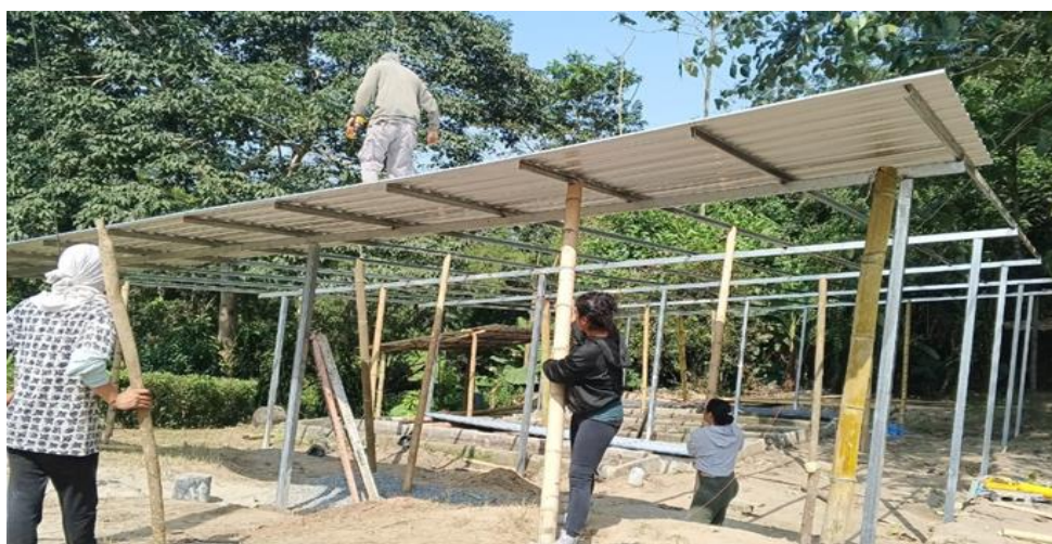
Figura 11. Elaboración de techado para lombricario.
