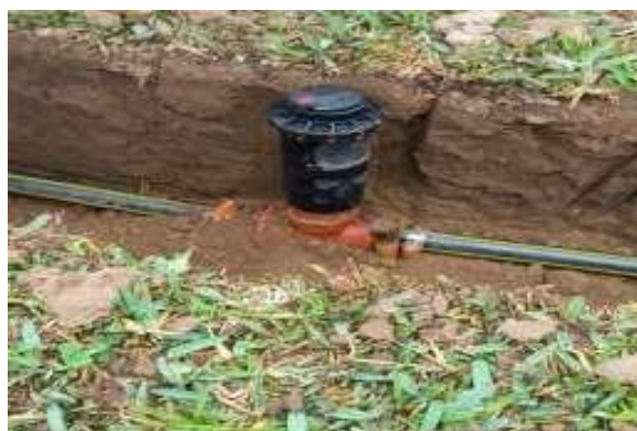
Anexo 7. Instalación de los aspersores del sistema. 1
