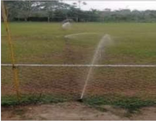
Anexo 8. Instalación del sistema de riego por aspersión 1
