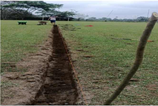
Anexo 10. Excavación de zanja lineal para las instalaciones. 1
