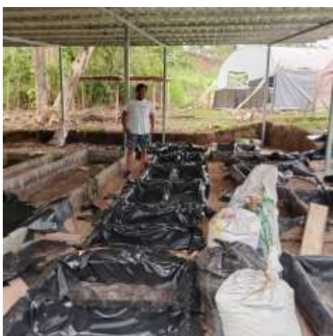
Construcción de las camas
