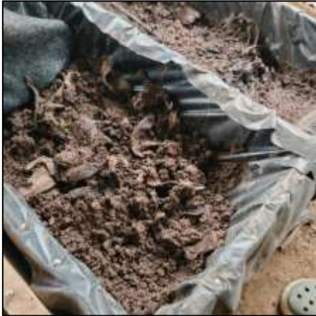
Instalación de los tratamientos.
