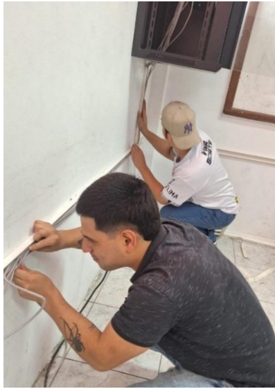
Ilustración 26 Instalación de canaletas y cables
