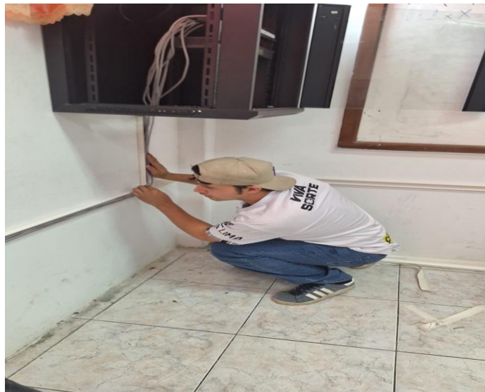
Ilustración 8 conexión de cableado
