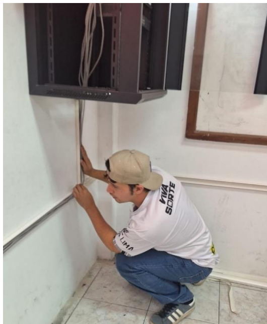
Instalación de canaletas y cables UTP
