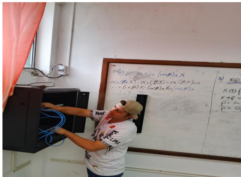
Ilustración 9 instalación de swicht
