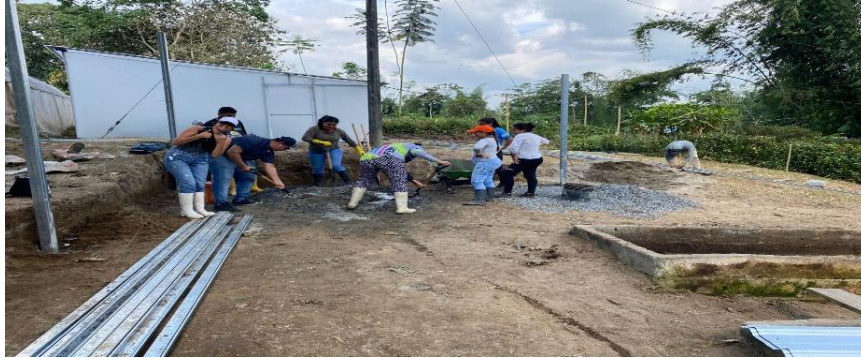
Figura 8. Acondicionamiento del terreno y conformación de la base estructural para el sistema del lombricario
