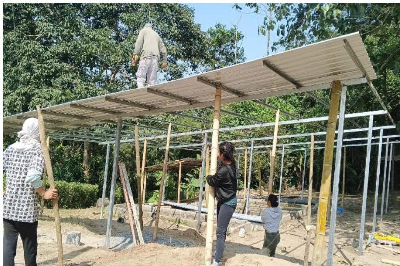
Figura 9. Colocación de la cubierta metálica en la estructura del sistema del lombricario
