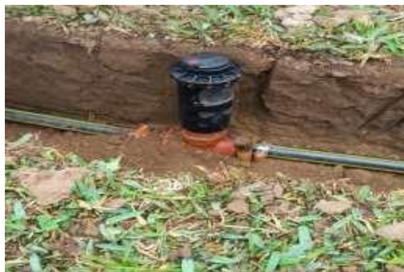
Anexo 7. Instalación de los aspersores del sistema. 1
