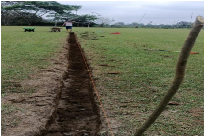
Anexos 10. Excavación de zanja lineal para las instalaciones. 1
