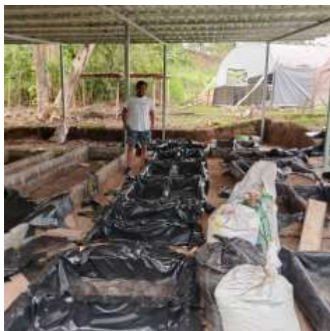
Construcción de las camas
