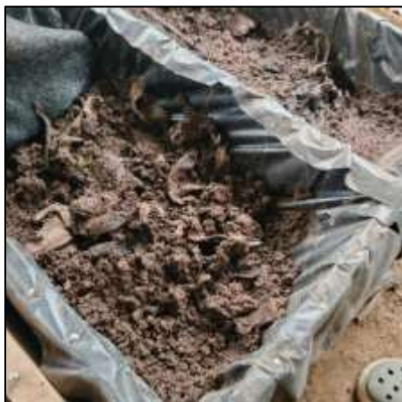
Instalación de los tratamientos.
