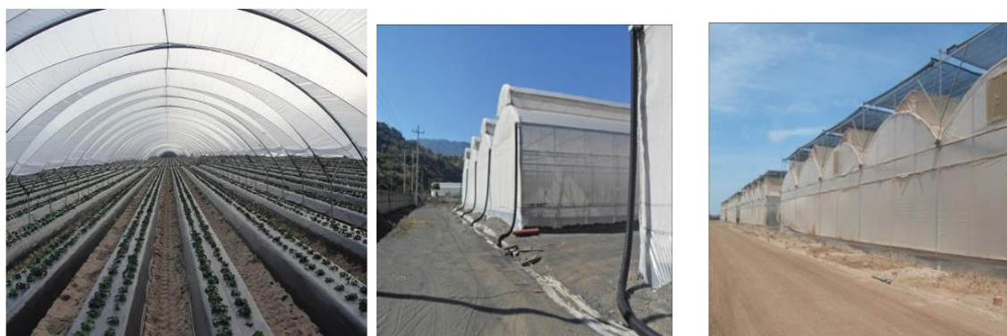
Figura 3. Macrotúneles con cubierta plástica Invernaderos con cubierta plástica y malla sombra en la parte superior
